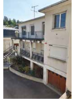
↳ Réhabilitation de l'ancien CCAS (ci-dessus) pour Initiative Seine Yvelines
