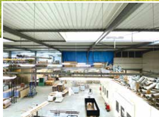
Skydomes Les locaux de Sequoia sont équipés de skydomes, hublots de toit servant de puits de lumière ainsi que de trappe de désenfumage lors des incendies.
